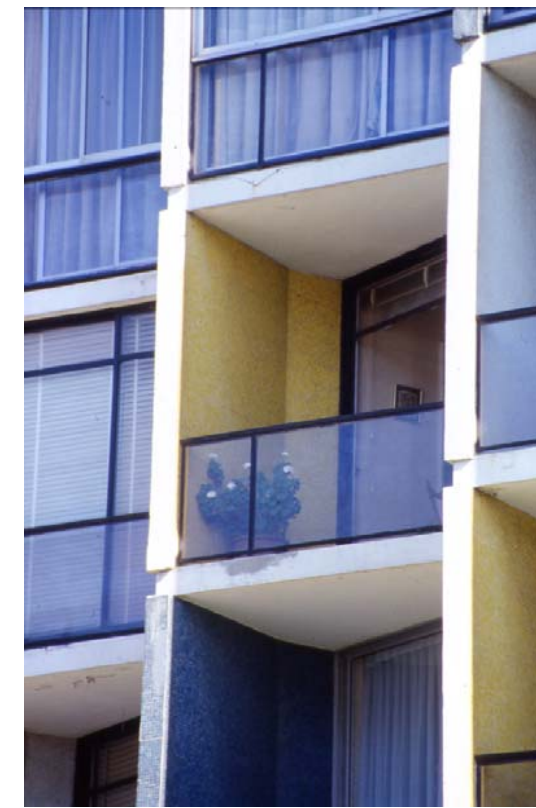
4 detalle balcón, con antepecho translucido, logrando el concepto de vano total
