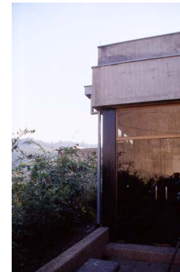
Vistas a detalles constructivos y caída de aguas lluvias. En la imagen de la izquierda se aprecia el falso rayado vertical simulando moldaje de madera, considerando que el sistema constructivo se llama covintec que consiste en planchas de polietileno Expandido envuelto en malla metálica y luego estucado. Por otro lado la imagen de la derecha deja a l descubierto una canaleta de aguas lluvias de hojalatería externa en contraposición al partido general de incorporarlas como parte del sistema constructivo. Nota aparte. Merecen las grietas del estuco producto del trabajo mecánico de los distintos materiales.
