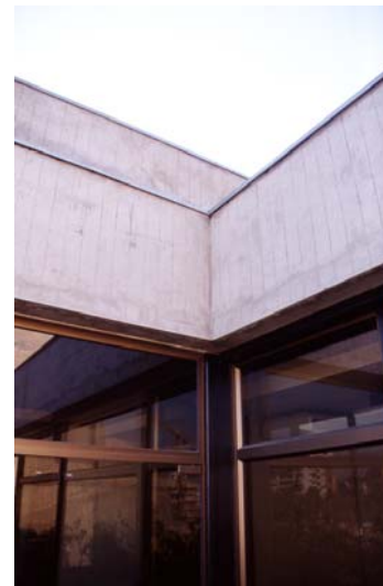
Vistas a detalles constructivos y caída de aguas lluvias. En la imagen de la izquierda se aprecia el falso rayado vertical simulando moldaje de madera, considerando que el sistema constructivo se llama covintec que consiste en planchas de polietileno Expandido envuelto en malla metálica y luego estucado. Por otro lado la imagen de la derecha deja a l descubierto una canaleta de aguas lluvias de hojalatería externa en contraposición al partido general de incorporarlas como parte del sistema constructivo. Nota aparte. Merecen las grietas del estuco producto del trabajo mecánico de los distintos materiales.
