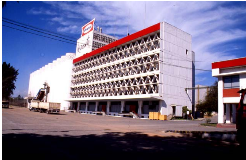
1 Perspectiva del conjunto, el contraste entre la opacidad de los silos y la transparencia del volumen flotante constituido por crucetas estructurales, producto del retranqueo del primer piso.
