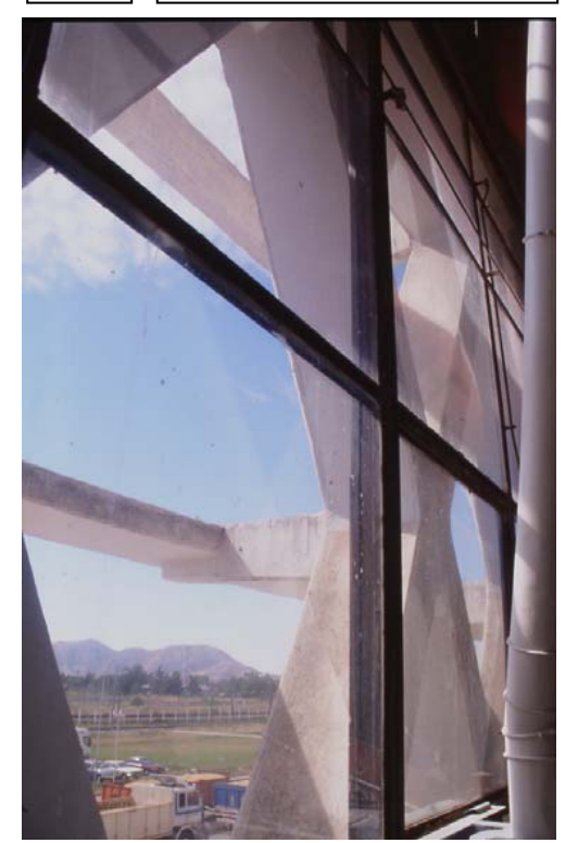
8 Vista desde el interior, el paso de la luz por medio de la estructura.
