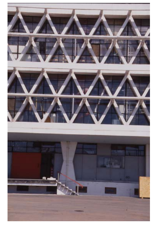
6 Transmitancia de fuerzas provenientes de la red de crucetas, descargadas en un pilar de tipo cruceta.
