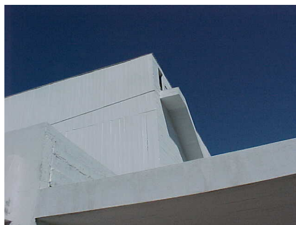
21 Salida posterior a la azotea del edificio. Trabajo laminar de la escalera.
