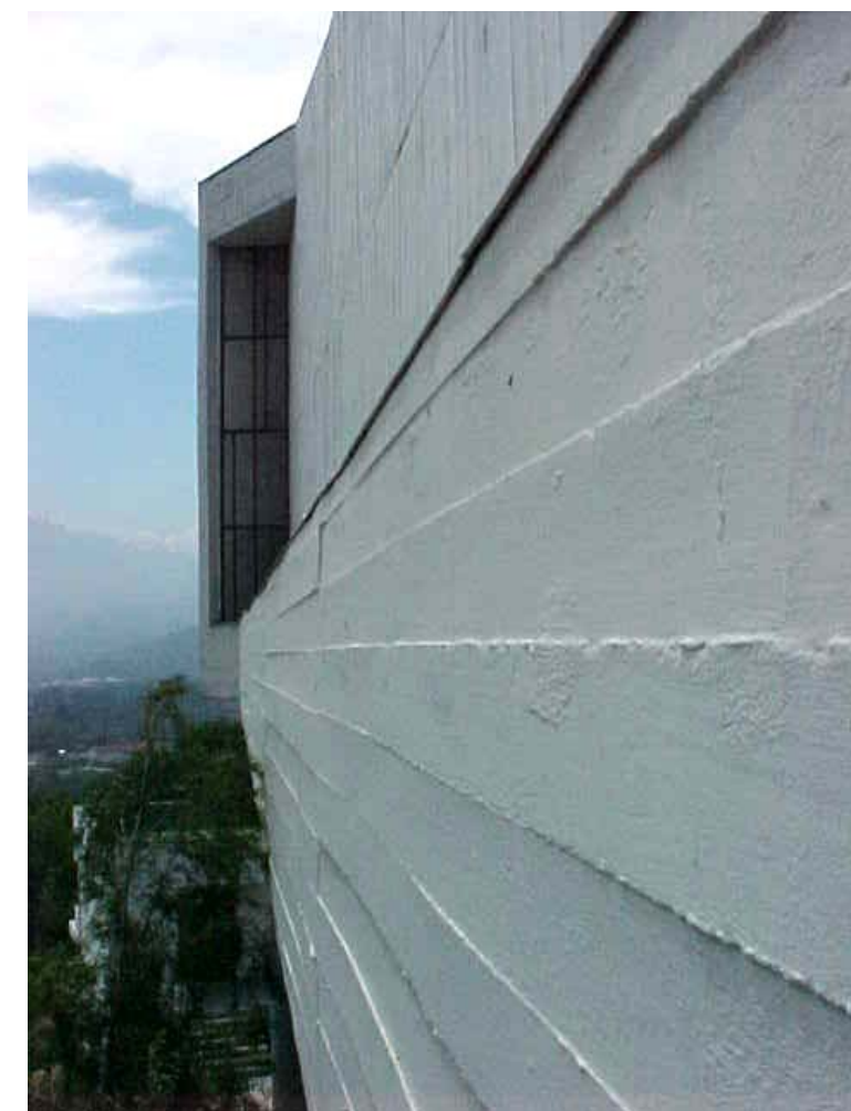
1 Detalle moldaje horizontal, perspectiva que corresponde al corredor de acceso hacia la virgen.
