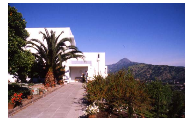
5 Paseo jardín interior hacia acceso posterior secundario capilla, con vista hacia el valle.
