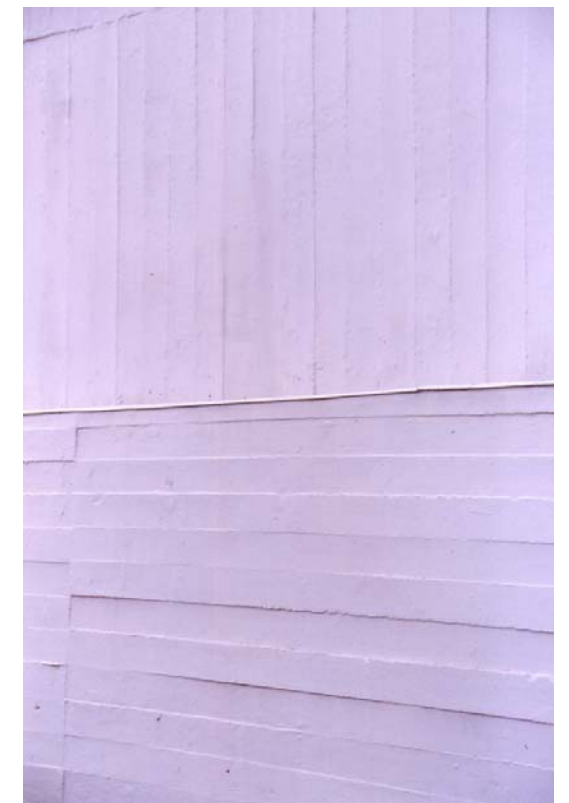
25 Trama del moldaje, contrate horizontal y vertical.
