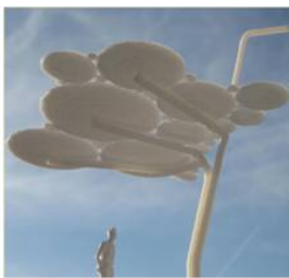
Cubierta e iluminación integrada
