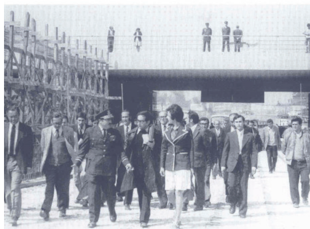
4-5.- Trazado e inspección de obras para Avenida Norte Sur.
