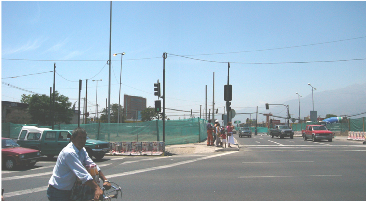
Figura 15: Paradero 14 Vicuña Mackenna. Comuna de La Florida. Santiago año 2004. La instalación de faenas de la construcción de la Autopista privada mantuvo la condición urbana que se muestra durante aproximadamente tres años.
