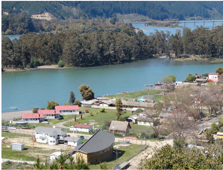
Foto 7: Vista parcial ribera sur, isla y terrazas desembocadura Río Maule, ciudad de Constitución; al fondo, puente sobre el río. (Fuente propia, año 2007).
